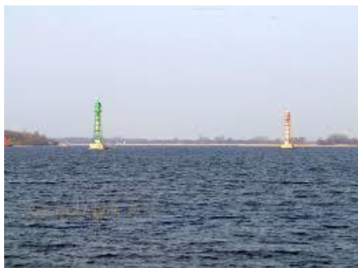
Rysunek 2. Zdjęcie Bramy Torowej (BT). Na Zalewie Szczecińskim, wzdłuż toru wodnego rozmieszczone są cztery Bramy Torowe.
